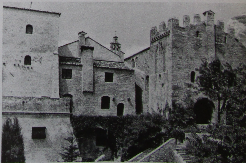
✂ Fig. 1. Monselice, complesso del Castello, veduta da sud.
